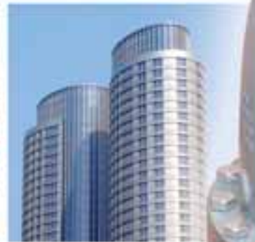
IMPIANTISTICA CIVILE CIVIL PLANTS
